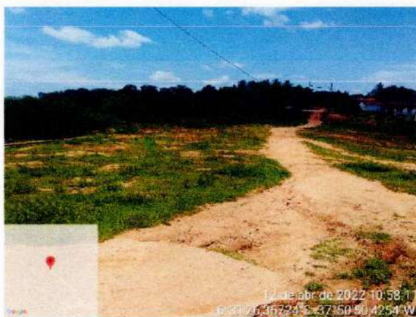
Sangradouro do açude Carneiro
