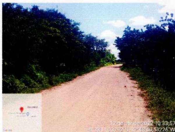
Término da passagem molhada e início da pavimentação pleiteada
