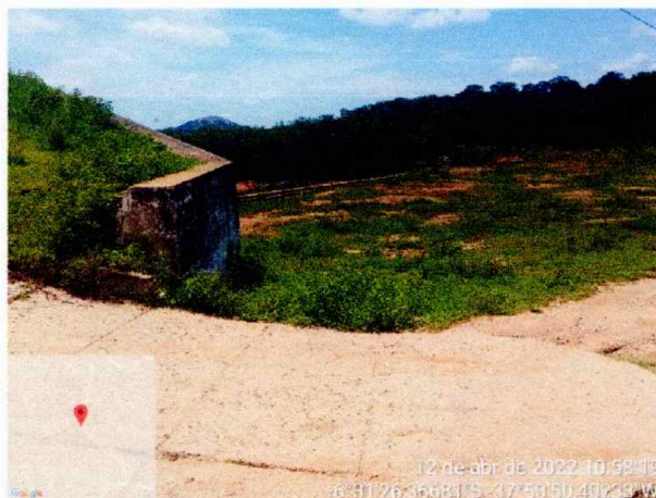
Início subida da parede do açude, junção com pavimentação projetada
