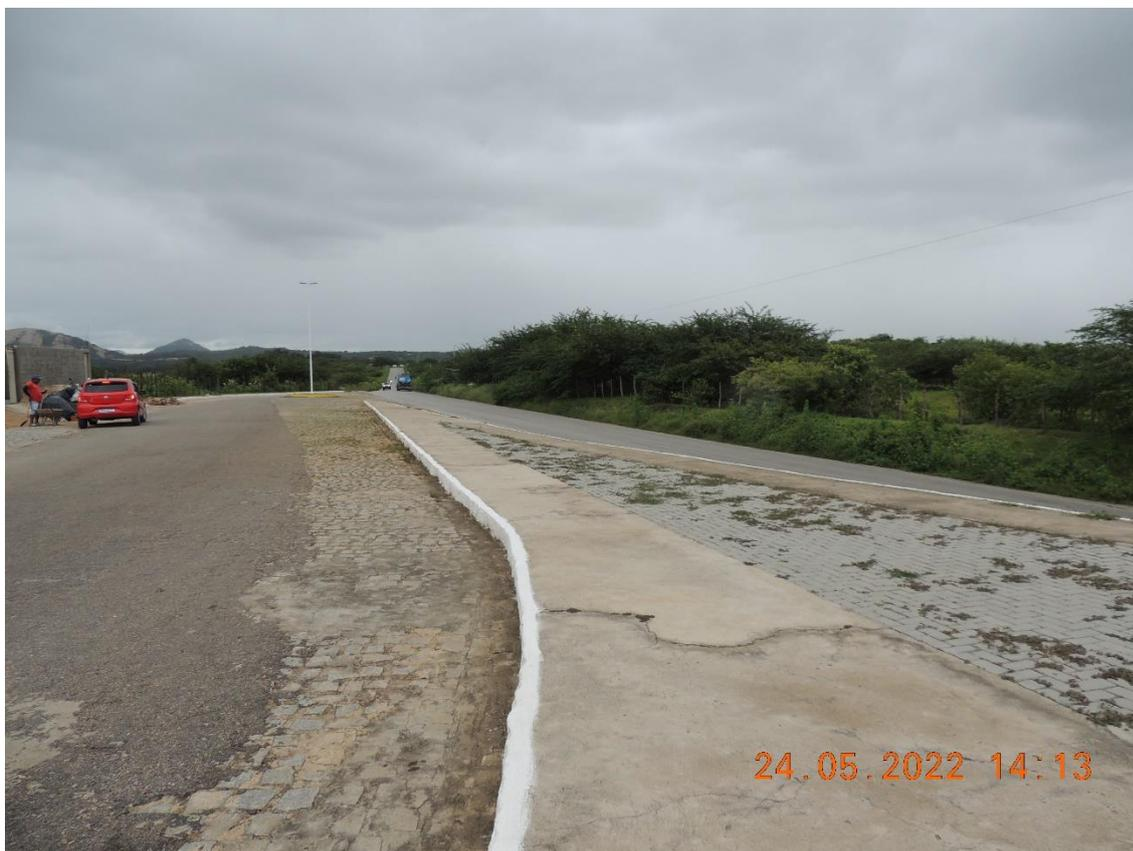
Nesta área será executado um muro de contenção em alvenaria de pedra, com altura máxima de 1,60m. Nas bordas que dão para desnível elevado de piso será instalado um guarda-corpo metálico. A área interna será aterrada e nivelada pelo município. O piso das bordas será tipo brotoeja e internamente será intertravado. Serão instalados postes e bancos, além disso, será construído um ponto de apoio ao passageiro.
