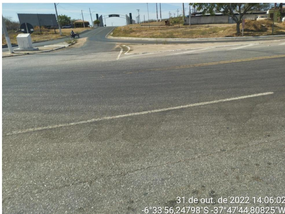
Canteiro lateral onde deverá ser removido o piso atual e executado o ponto de apoio ao passageiro, um poste com luminária dupla de LED e piso intertravado com piso tátil de contorno.
